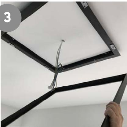
Plaats na montage van de basisplaat de valbeveiliging opnieuw, en verbindt de 230V aansluiting van de driver. Plaats het paneel in het frontkader en veranker het. Sluit de driver aan op het ledpaneel.
