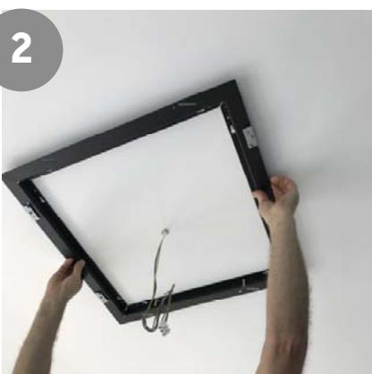
Plaats de basisplaat op de gewenste positie, markeer de 4 bevestigingspunten en monter de basisplaat.
